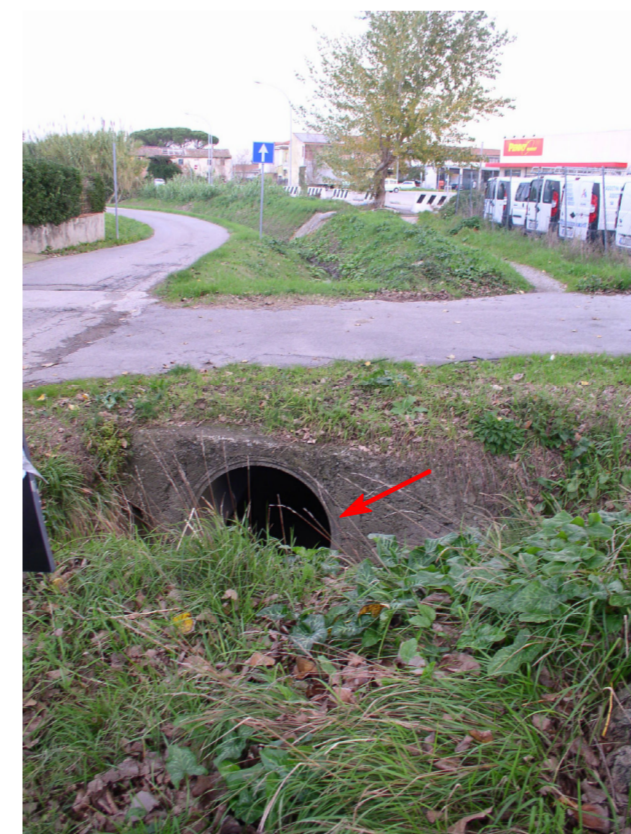
Foto 5: Tombamento già esistente sul Fosso Rotina
