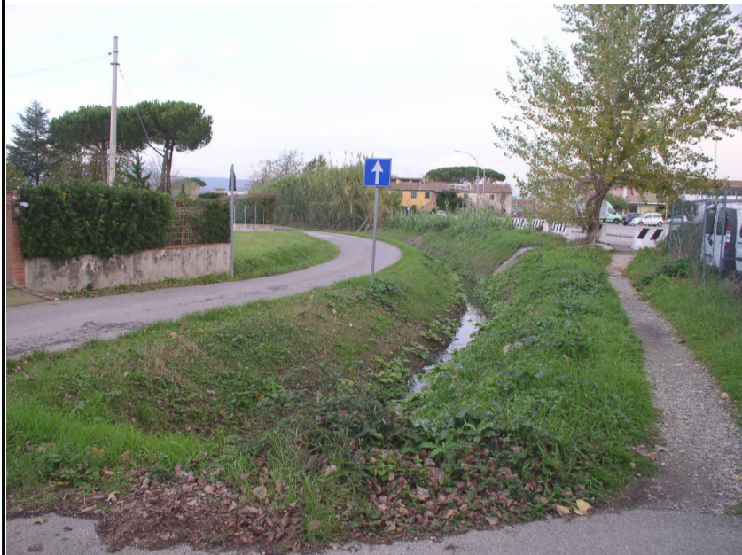
Foto 6: Il Fosso Rotina a valle dell'area in oggetto
